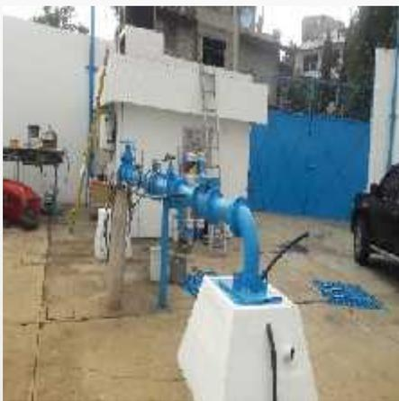
10. Perforación exploratoria en 12", ampliación de pozo de 12" a 18" de diámetro, y de 18" a 24" de diámetro, hasta 300 m de profundidad, equipamiento (bomba sumergible de 50hp-150hp, columna de 8" de diámetro sistema eléctrico para 50hp-150hp, subestación eléctrica de 150kva, acometida eléctrica en 23 kv) e integración al sistema de operación del sistema de
